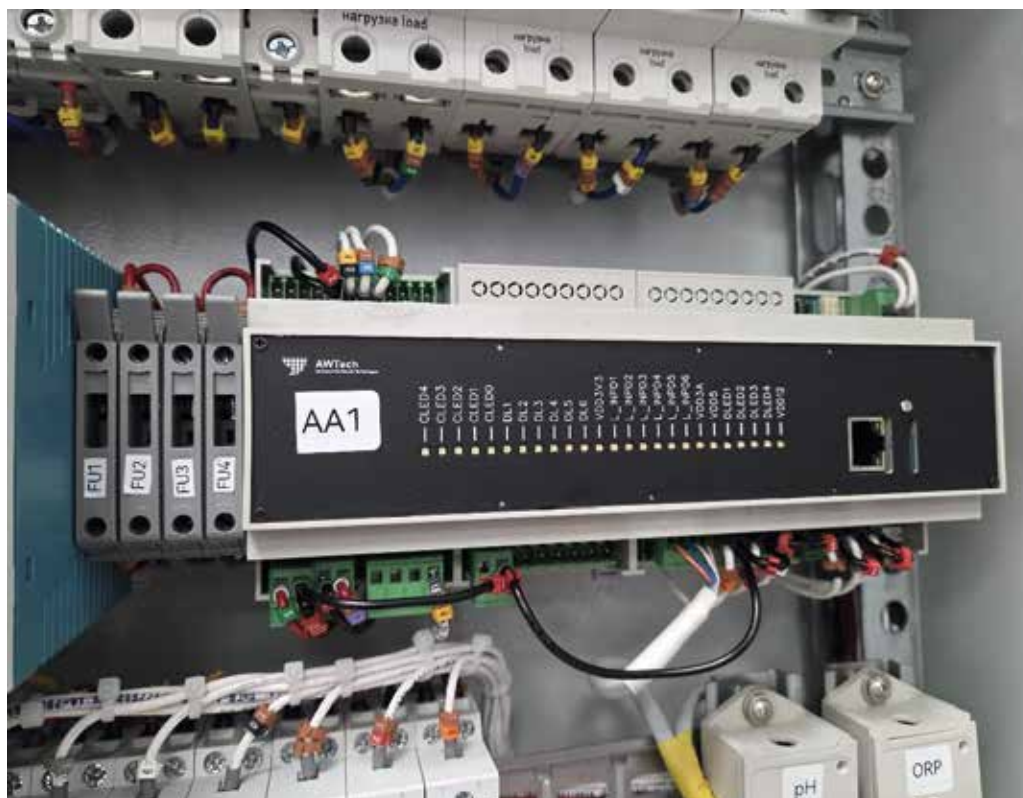
На фото: Свободно программируемый контроллер (ПЛК) собственного производства компании АВТех (Россия) для управления выпускаемым технологическим оборудованием.
